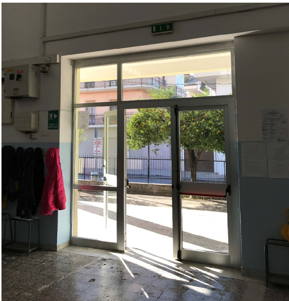
Fig. 6 Infisso esterno ingresso principale in alluminio a vetro singolo
