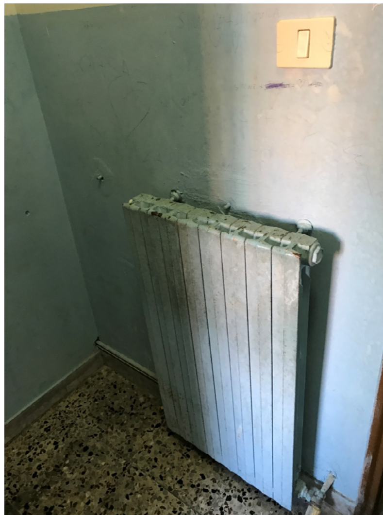
Fig. 8 Elemento scaldante tipo privo di valvole di regolazione
